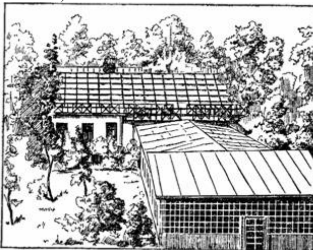
Рисунок 107. Солнечная водонагревательная установка в Туркменской ССР.
