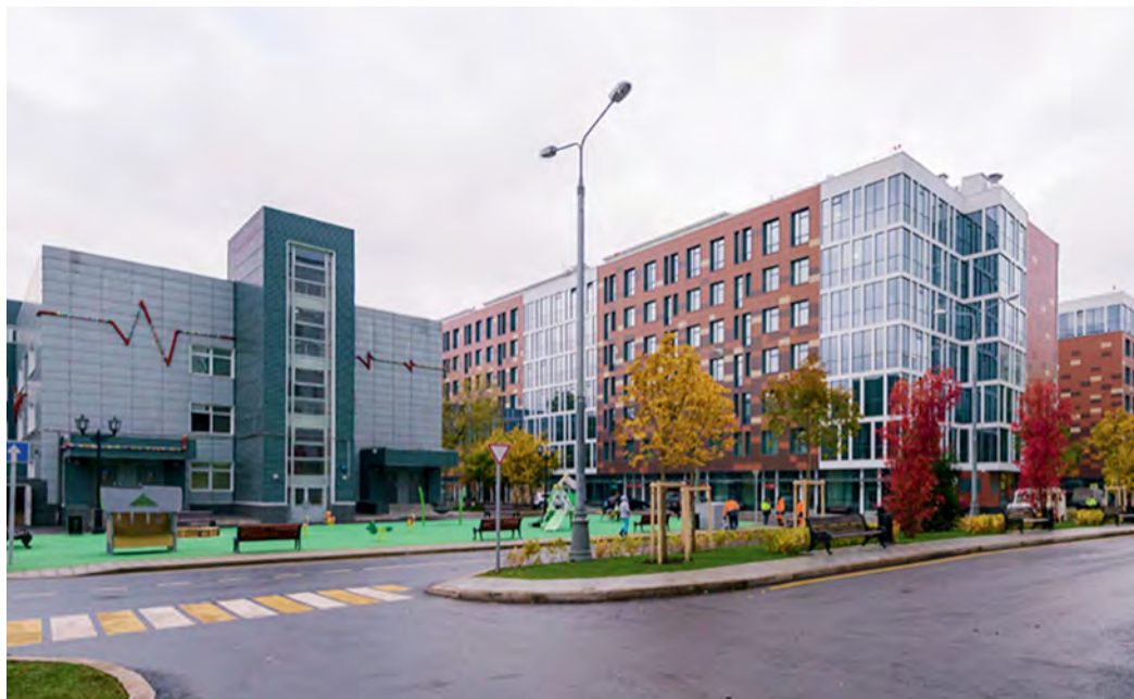
Новый корпус Морозовской больницы.
