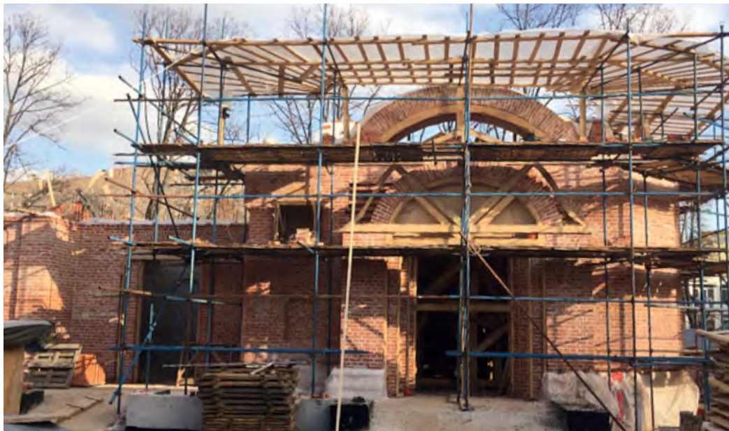
Храм Покрова в октябре 2019 г. (строительство)
