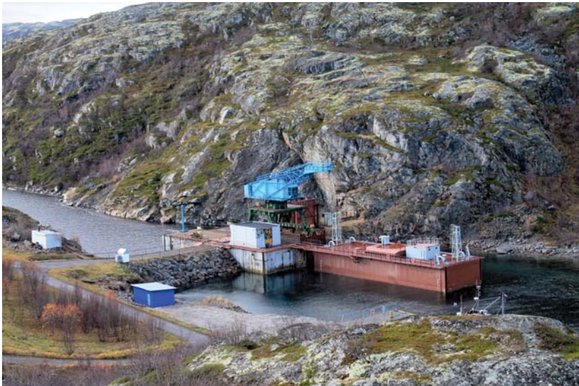
Рис. 8.24. Кислогубская ПЭС – единственная в России приливная электростанция. Расположена в 27 км от Мурманска, в губе Кислая Баренцева моря, где высота приливов достигает 5 м. Станция состоит из двух частей: старой, 1968 г., с французским гидроагрегатом мощностью 0,2 МВт, и новой, 2006 г., с отечественным агрегатом на 1,5 МВт. Находится на государственном учете как памятник науки и техники.
